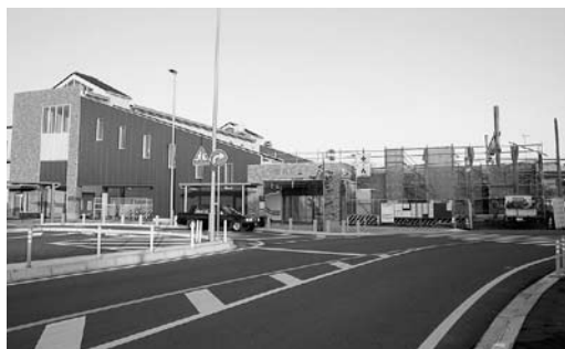
平成28年に橋上駅舎が完成した川俣駅前
